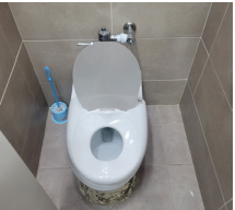
화장실 시설 개선
