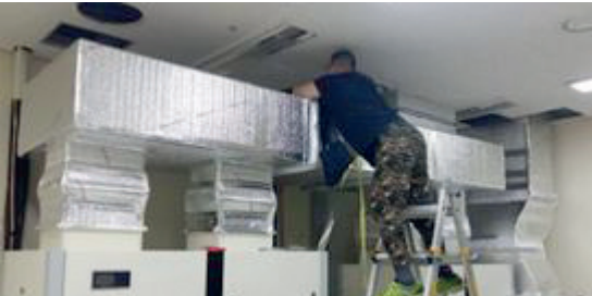
(수장고전실 향온항습기 설치공사)
